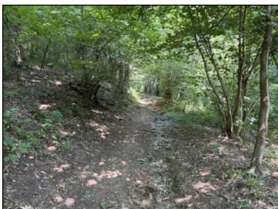
FOTO 3: EROSIONE CARREGGIATA
